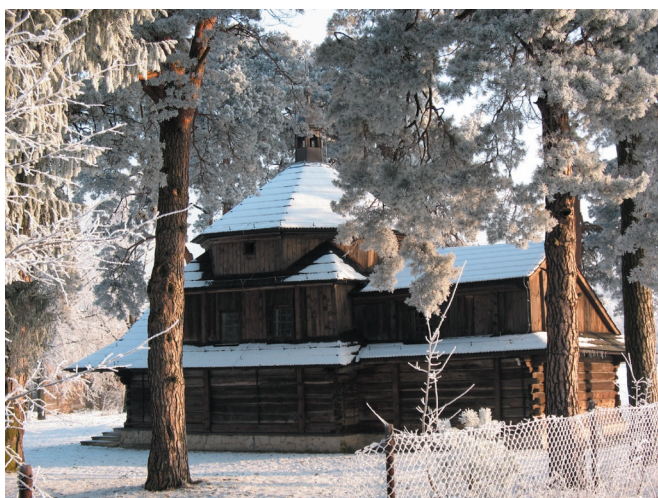
Bełżec. Drewniana cerkiew grecko - katolicka p.w. Św. Bazylego Белжець. Дерев'яна греко- католицька церква св. Василя
