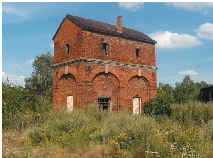
Водонапорна башня у Белжеці Wieża ciśnienia w Bełżcu
