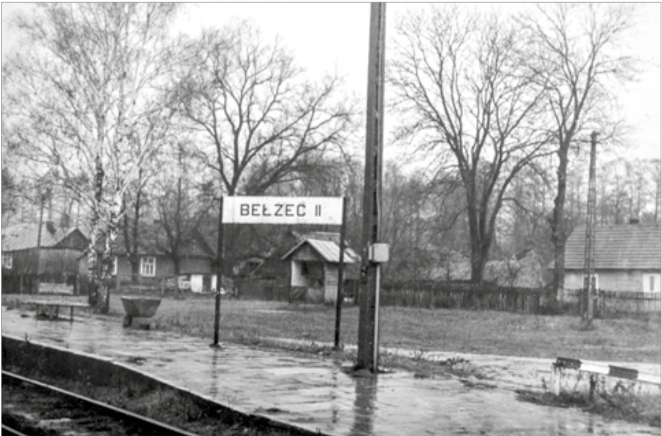
Ryc. 63. Przystanek kolejowy w Bełżcu II, wg P. Sygowskiego 1990.
