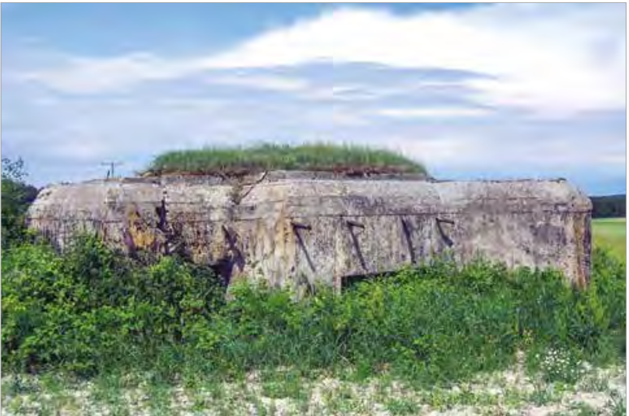
Fot 35. Szalenik-Kolonia, bunkier z linii Mołotowa
