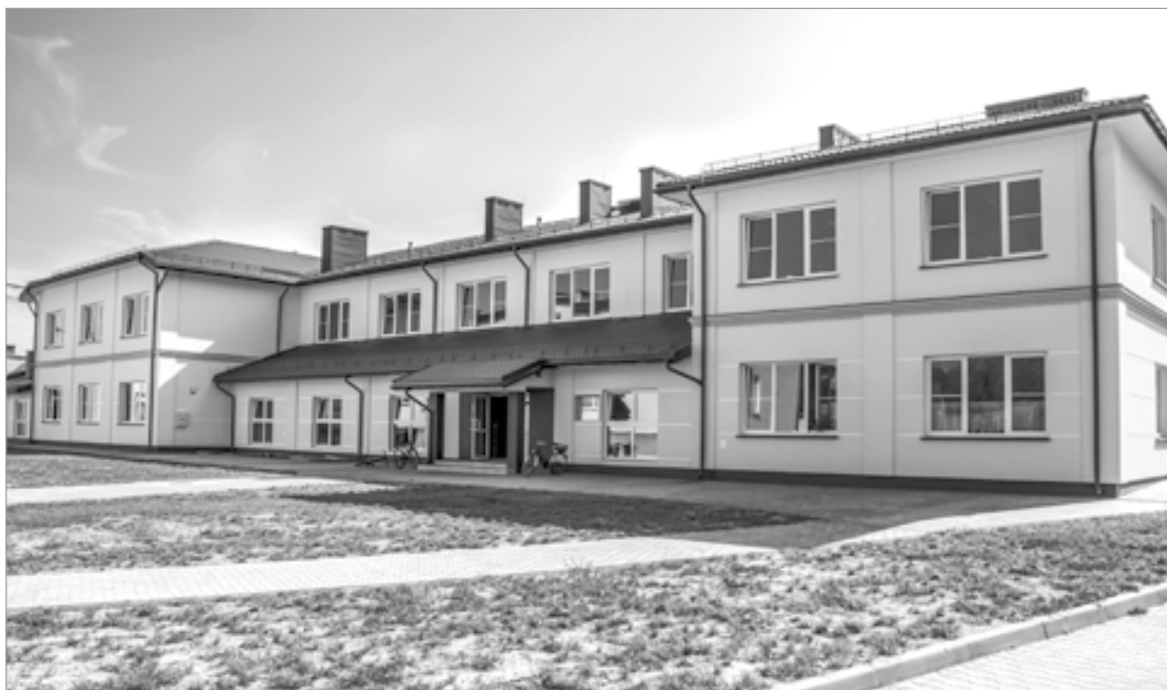
Ryc. 81. Budynek Gimnazjum w Bełżcu wybudowany w 2015 roku, fot. ze zb. UG w Bełżcu.
